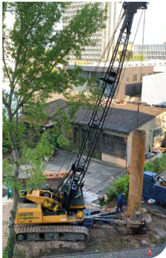
Bohrung der Brunnenanlage für nachhaltige und regenerative Energiegewinnung.
