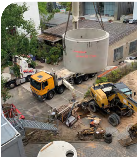
Die Sickerschächte werden eingegraben.
