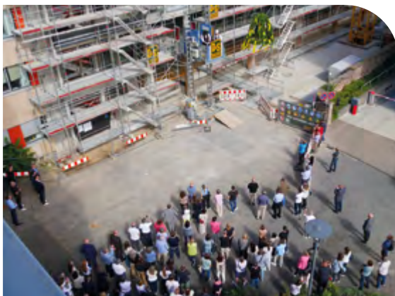
Richtfest des EZVK-Erweiterungsbaus am 20. September 2023.
