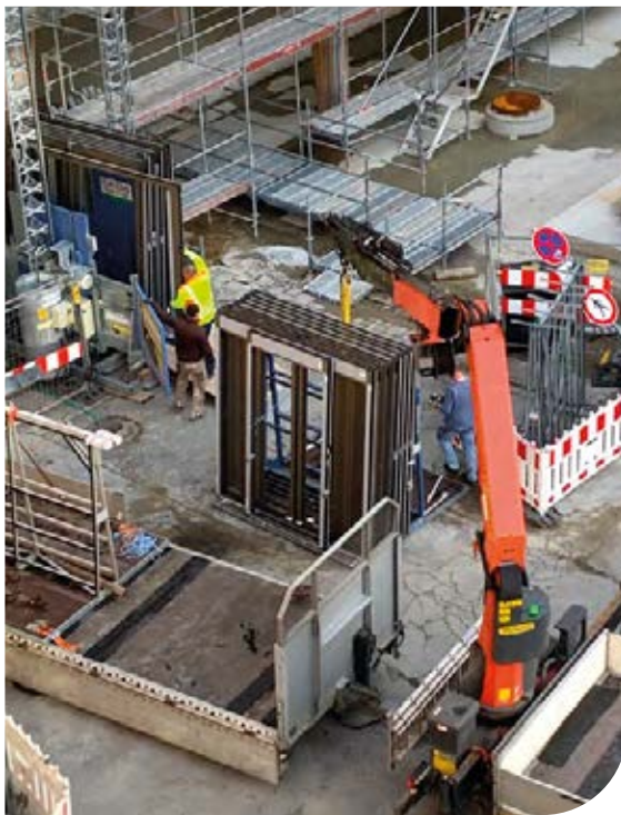
Teile der neuen Fassade werden angeliefert.
