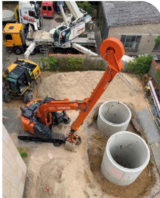
Sickerschächte sorgen dafür, dass das Regenwasser auf dem Grundstück versickern kann.
