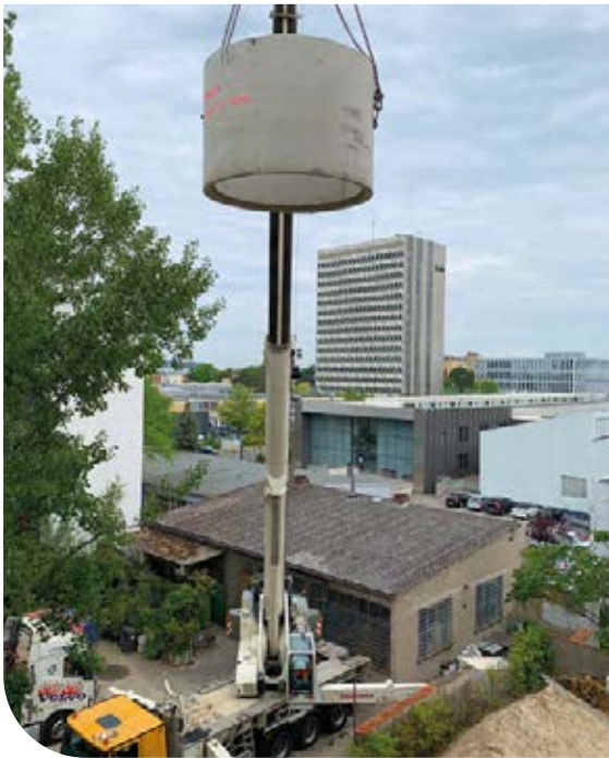
Sickerschächte sorgen dafür, dass das Regenwasser auf dem Grundstück versickern kann.
