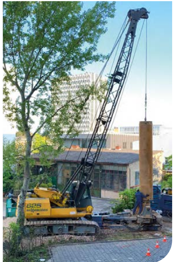
22. April 2022: Die Brunnenanlage für nachhaltige und regenerative Energiegewinnung wird gebohrt.
