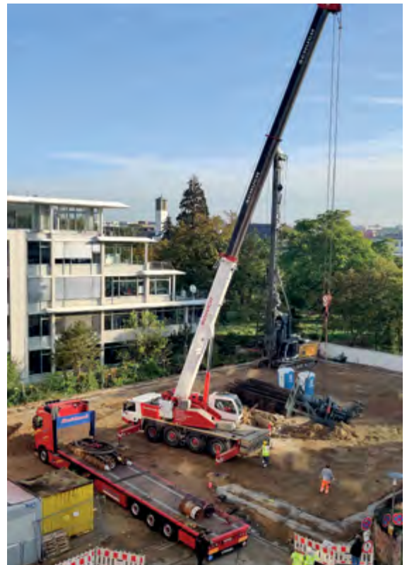
Im September 2021 war ein Schwerlasttransporter nötig, um die für das Fundament notwendigen Baumaschinen anzuliefern.
