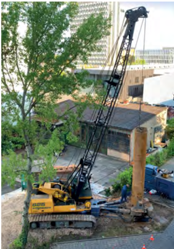
Bohrarbeiten für die Geothermie-Anlage auf der Rückseite unseres Bürogebäudes.
