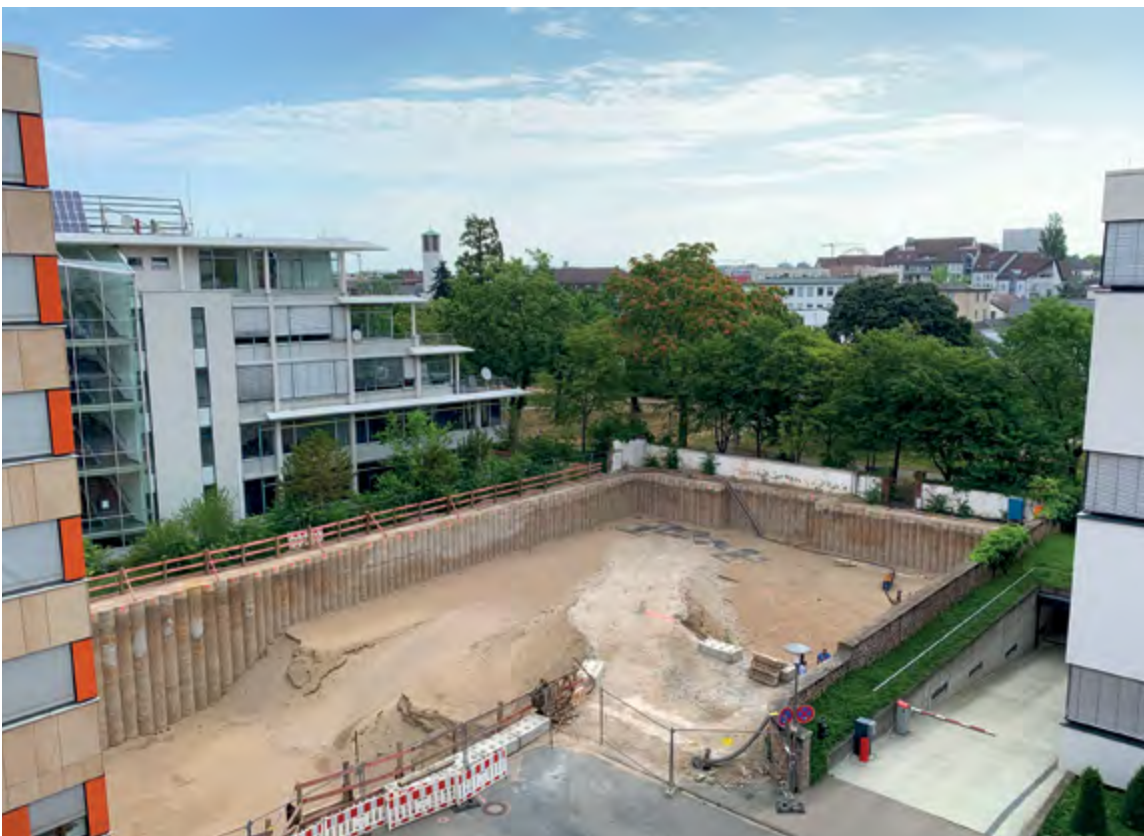
Blick auf die Baustelle zum Zeitpunkt der Drucklegung dieser Broschüre. Zu dieser Zeit finden viele unterschiedliche Vorarbeiten zur Vorbereitung der Rohbauarbeiten statt, die vorraussichtlich bis zum Frühjahr 2023 ausgeführt werden.
