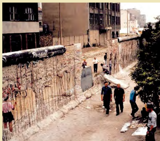
Mauerspechte bei der Arbeit
