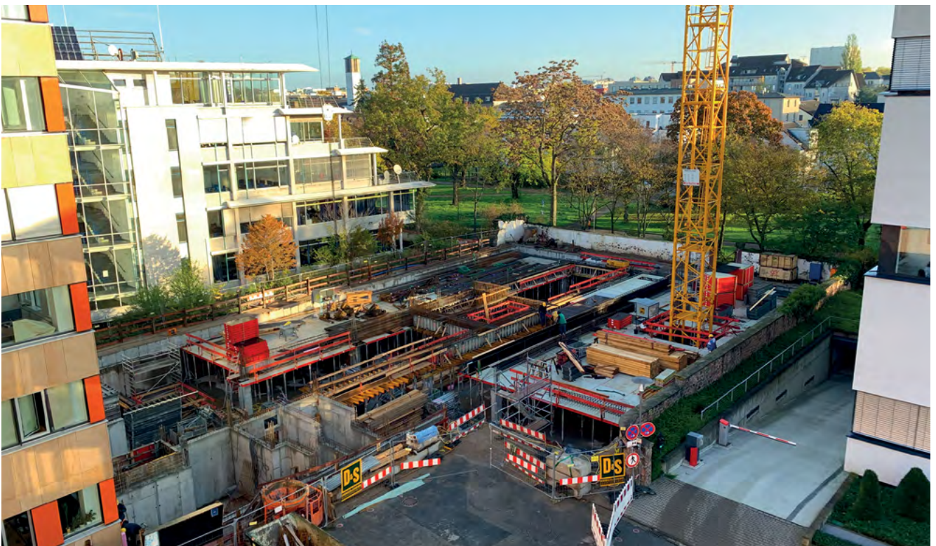
Es geht voran: Blick auf die EZVK-Baustelle an einem ausnahmsweise sonnigen Novembervormorgen 2022.
